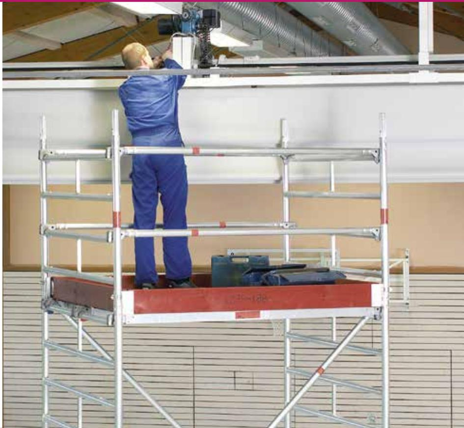
**La torre UniCompacto es un práctico y sencillo andamio con doble ancho de plataforma. Permite alcanzar alturas de trabajo de hasta 7,2 m. sin precisar vigas de inicio. Con un área de trabajo intermedia entre las torres UniEstándar y UniAncho.**
