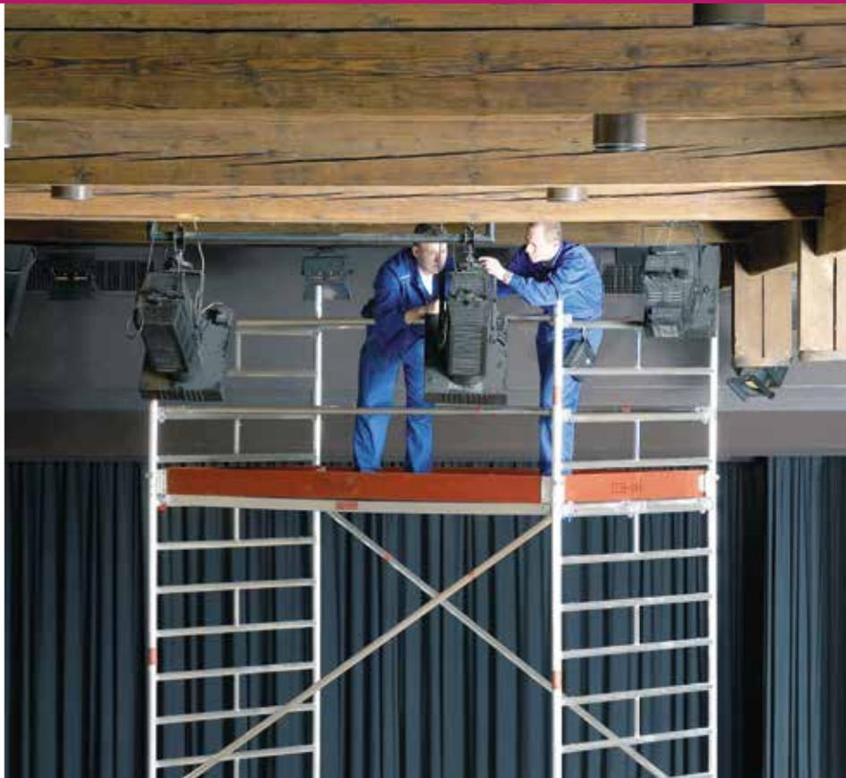
**Andamio móvil universal con plataforma de doble anchura lo que supone un amplio espacio de trabajo, muy útil para obras en altura.**
