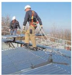
Un sistema que proporciona la seguridad necesaria para evitar la caída en altura durante el montaje de la cubierta Casette de Layher, sin mermar la comodidad necesaria en el montais
