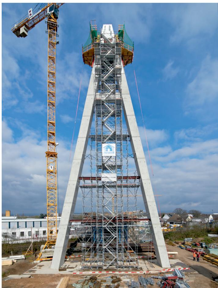
**E**n el sistema de Cimbras Allround TG60 la seguridad en el montaje va integrada, pudiendo ser montada tanto en posición horizontal como en posición vertical, siendo su capacidad de carga por montante vertical de 6 toneladas. Esta cimbra se puede utilizar tanto para encofrar un forjado como para, sin desmontarla, encofrar pilares, estando preparada para ser elevada y transportada mediante grúa o bien con ruedas. Su sistema de montaje, totalmente seguro, cumple con la norma EN 12812:2008-12. //
