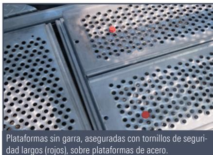
Plataformas sin garra, aseguradas con tornillos de seguridad largos (rojos), sobre plataformas de acero.
