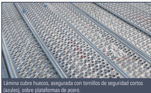
Lámina cubre huecos, asegurada con tornillos de seguridad cortos (azules), sobre plataformas de acero.
