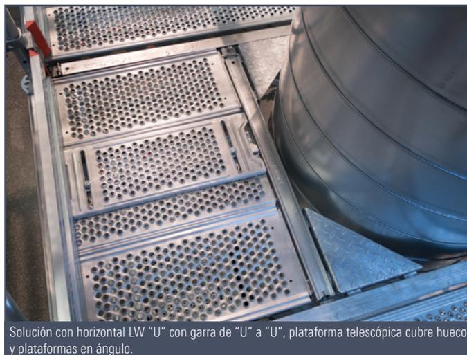
Solución con horizontal LW "U" con garra de "U" a "U", plataforma telescópica cubre huecos y plataformas en ángulo.
