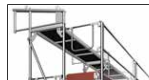
La barandilla perimetral superior, se monta de forma segura gracias a los niveles inferiores de ménsulas.
