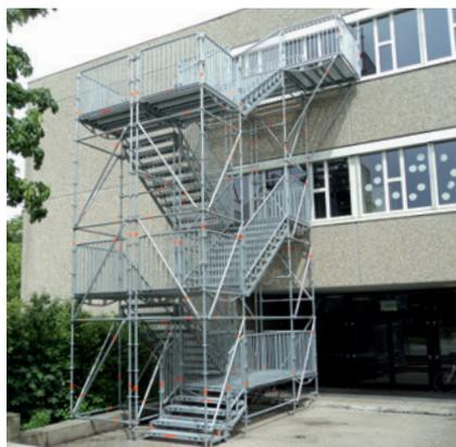
**Adaptación de los niveles de entrada y salida** en el área inferior o superior de las escaleras, usando niveles de igualación con diferentes alturas.
