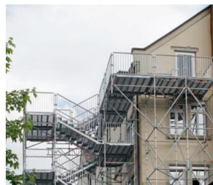
Para que las escaleras de emergencia puedan ser **accesibles desde diferentes puntos del edificio**, se pueden proyectar pasillos en el nivel superior, que pueden ser realizados completamente con piezas estándar del sistema Allround.
